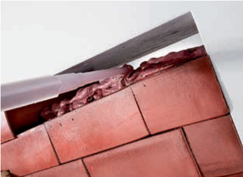
Poza 1: Cărămidă antifoc combinată cu spumă antifoc CFS F FX
